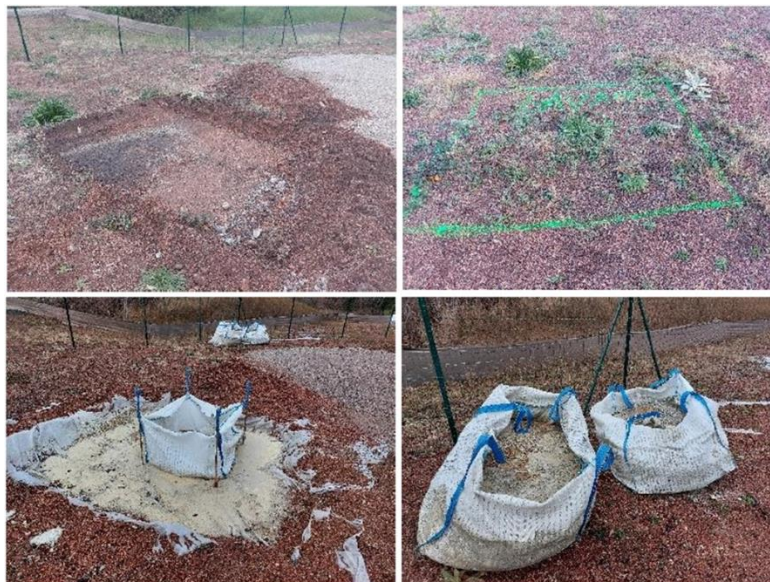
Mise en place d'une zone de stockage étanche
